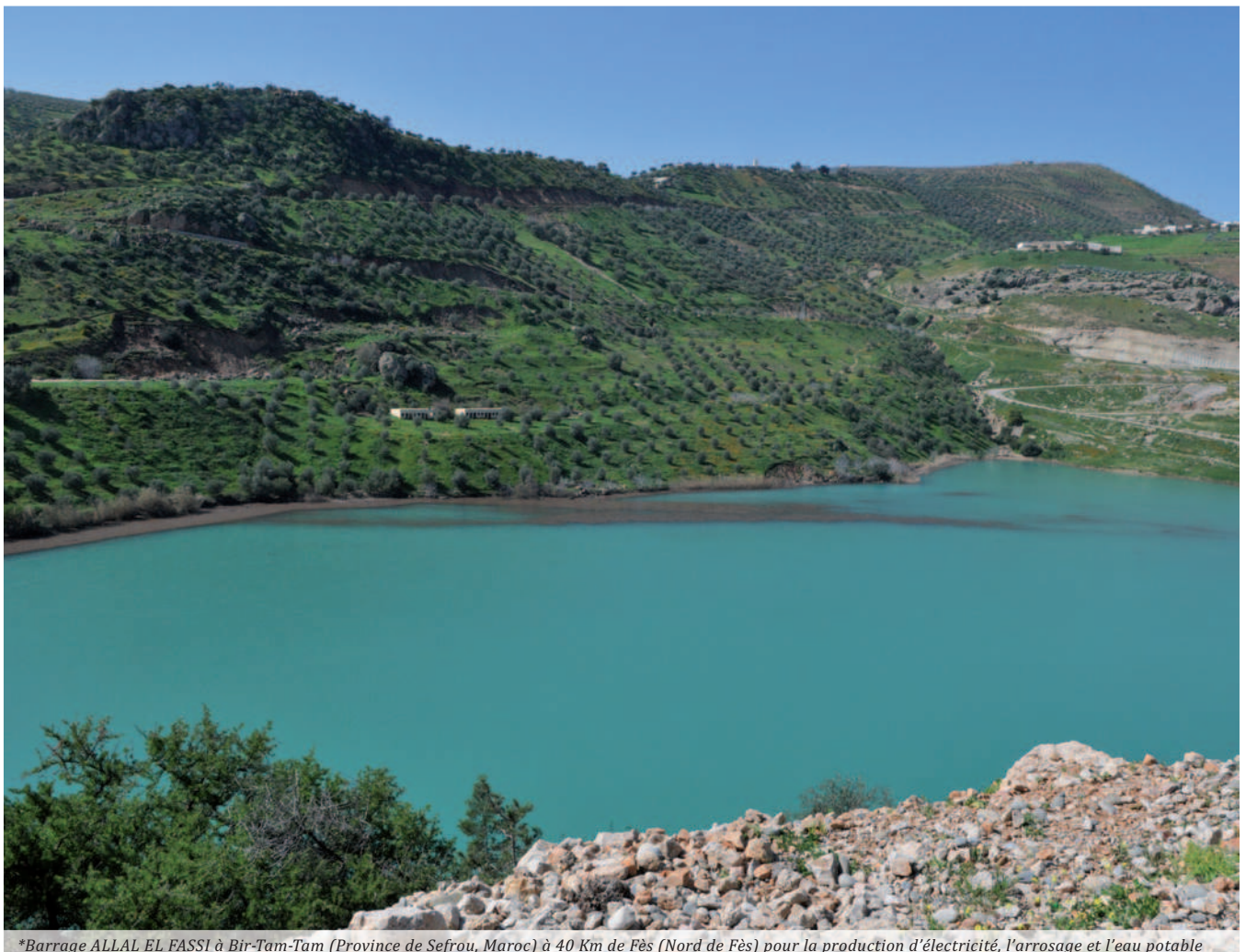
*Barrage ALLAL EL FASSI à Bir-Tam-Tam (Province de Sefrou, Maroc) à 40 Km de Fès (Nord de Fès) pour la production d'électricité, l'arrosage et l'eau potable
